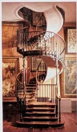
Dès 1895, l'architecte Albert Lafon surélève la façade et aménage deux ateliers reliés par un escalier métallique en spirale.
